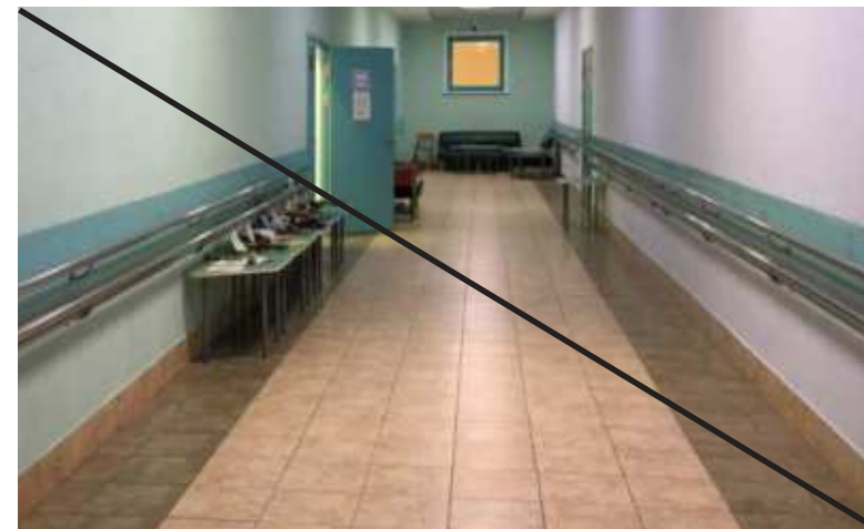
Плохо Керамогранитная плитка с крупными швами
