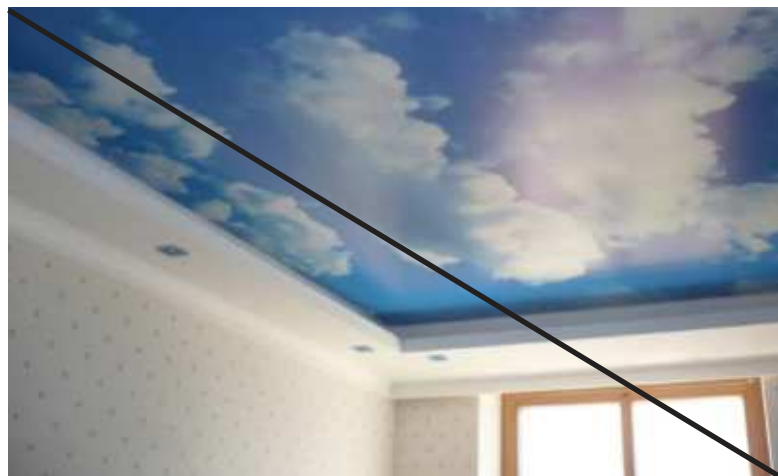
Плохо Натяжные потолки. Потолки с рисунками
